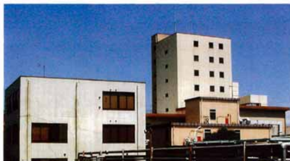
エネルギー・環境事業部 技術センター
