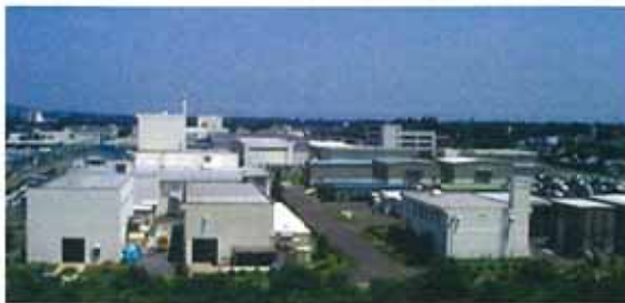
▲ 那珂エネルギー開発研究所
