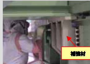
補強材の設置
