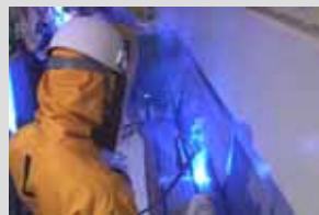
補強材取り付けにともなう溶接工事
