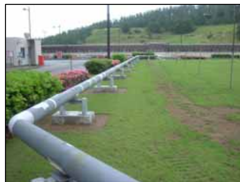
消火系配管復旧状況（地上化、火災対策）
