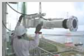
制震装置の設置
