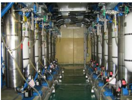
1号機制御棒駆動系水圧制御ユニット
