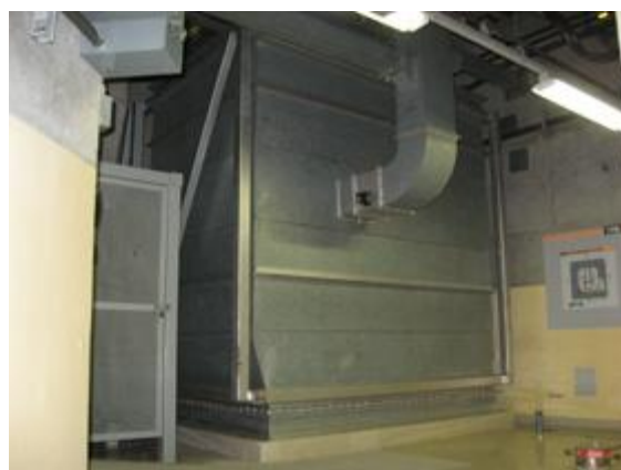
1号機 原子炉建屋給気ダクト
