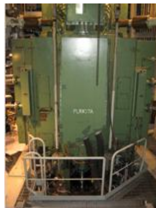
1号機 原子炉冷却材再循環ポンプ
