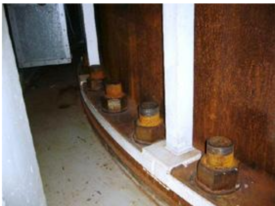
1号機 原子炉圧力容器基礎ボルト
