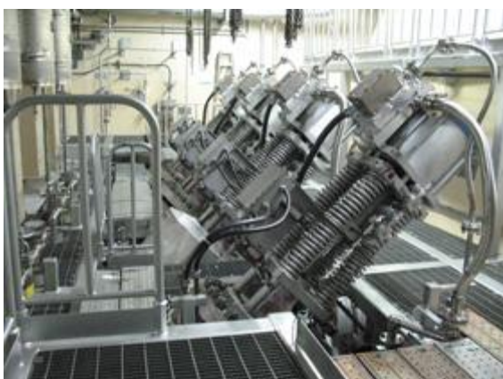
1号機 主蒸気隔離弁
