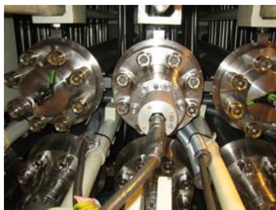
1号機 制御棒駆動機構
